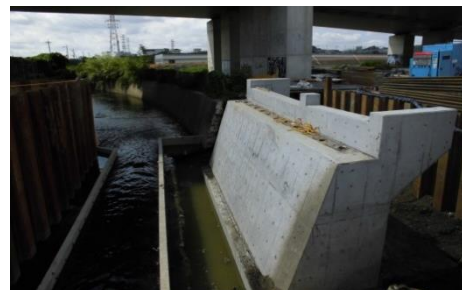
3. 根川に橋を架けるため、基礎工事を進めています。
