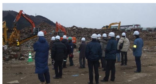
▲女川町を視察される地元環境対策委員の方々
