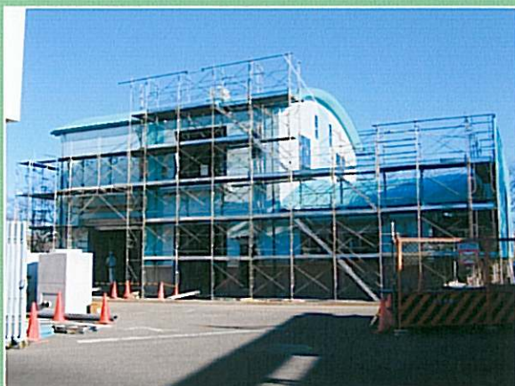
▲新「し尿処理施設」工事現場写真(12/21現在)。
