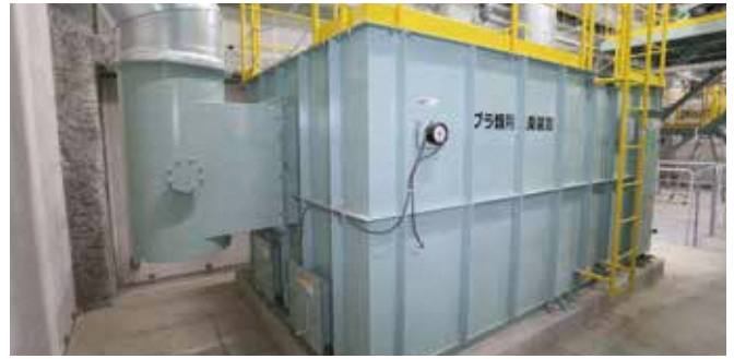
⑧ プラスチック類用脱臭装置・不燃粗大用脱臭装置 各所から発生する臭気を活性炭で吸着して、クリーンな空気として屋外に排気します。
