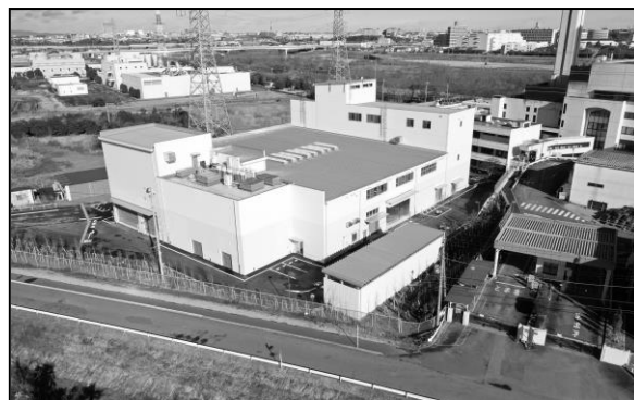
日野市クリーンセンター (プラスチック類資源化施設)
