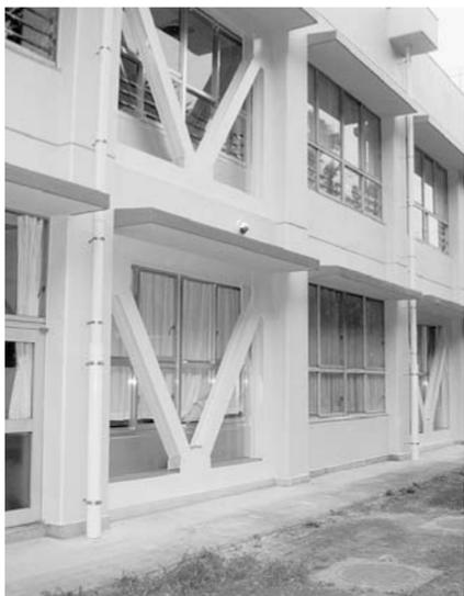
阪神淡路大震災後に改正された耐震基準に適合するように統合対象校を除き、小・中学校校舎及び体育館の耐震補強工事を行っています。校舎については、平成19年度に行っている旭が丘小、東光寺小、三沢中、大坂上中の工事で終了します。なお、平成18年度に「建築物の耐震改修の促進に関する法律及び施行令」の改正で新たに対象となった校舎は、平成19年度に耐震診断を行い、その結果に従う計画です。また、体育館は、平成21年度終了の計画になっています。平成19年度は、三小、三中で工事を実施しています。
