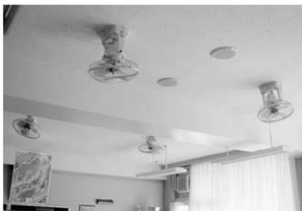
教室内の暑さ対策として、小・中学校の教室の天井に扇風機を設置しています。平成17年度は3・4階の普通教室、平成18年度は2階の普通教室、平成19年度には1階の普通教室に設置しました。平成20年度に残りの特別教室に設置を予定しています。
