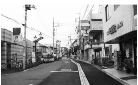
▲百草園駅周辺のバリアフリー化として整備された「おもいやり歩道」
