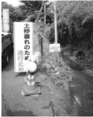
土砂崩れのため通行止め
