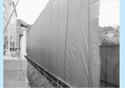
※農薬を散布する際に使用される防葉シャッター。市では、この防葉シャッターに対して補助金を出すなどの支援をしています。
