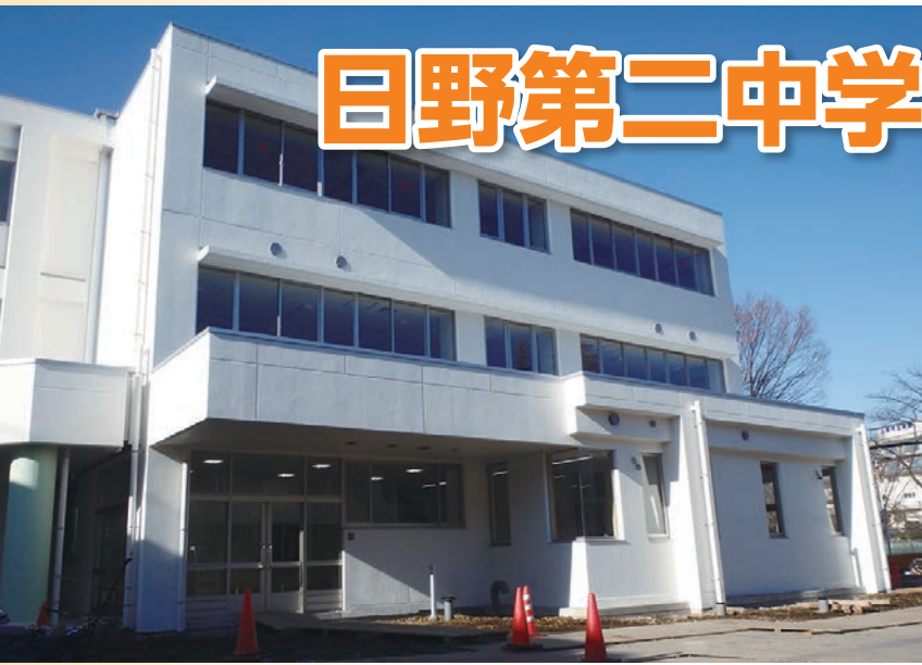
エレベーター設置
