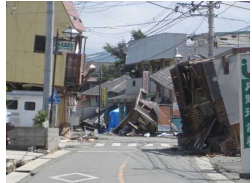
地震で損壊した建物
