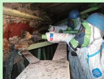
吹付け石綿の除去作業の様子
