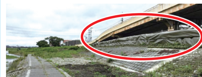
滝合橋下右岸の様子
