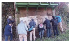
▲日野煉瓦でできたJR中央線多摩川橋梁の橋台
