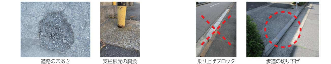
道路の穴あき 支柱根元の腐食 乗り上げブロック 歩道の切り下げ
