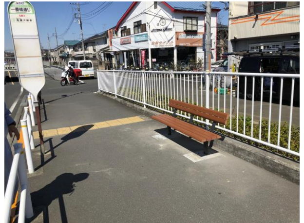
ベンチ設置完了写真（高幡不動駅方面）
