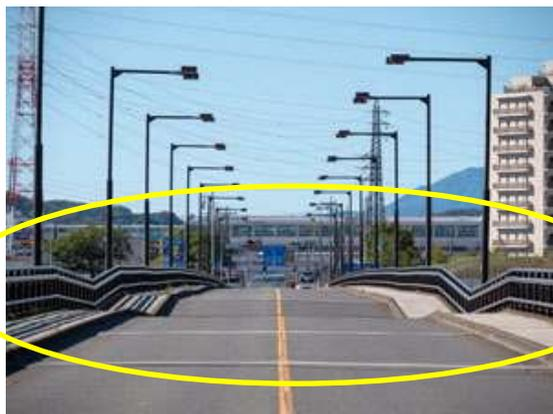
図 50.台風後の橋桁が落ちて波打つ日野橋
