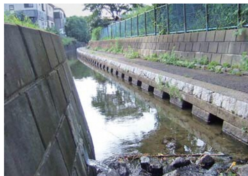
下堰魚巢ブロック
