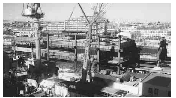
▲工事が進む高幡不動駅
