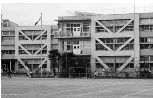
▲耐震補強工事を実施した一小
