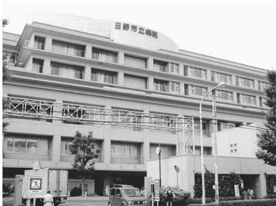
▲災害拠点病院としての整備
